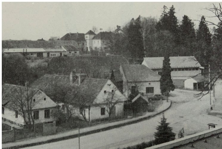
Pohled z kulturního domu. V pozadí budova státního statku a bývalého zámku Vysoký Hrádek, který dnes používá ČEZ jako informační středisko pro JE Temelín.
