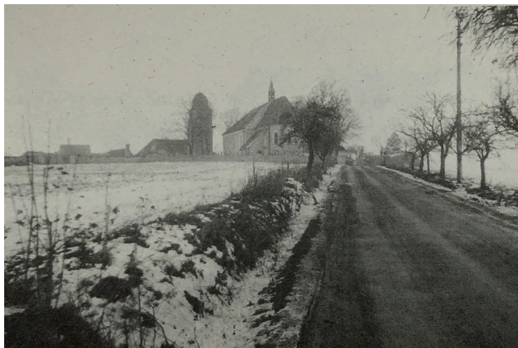
Budějovická silnice do Křténova. V pozadí dominanta kostela sv. Prokopa, jehož stavba se dochovala jako jediná až do dnešních dnů.
