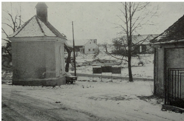
Stejná část Březí jako na horním snímku, ale už po částečné demolici. Zajímavé je, že z vesnic obyčejně zůstaly jen staré kapličky, které elektrárna opravila.
